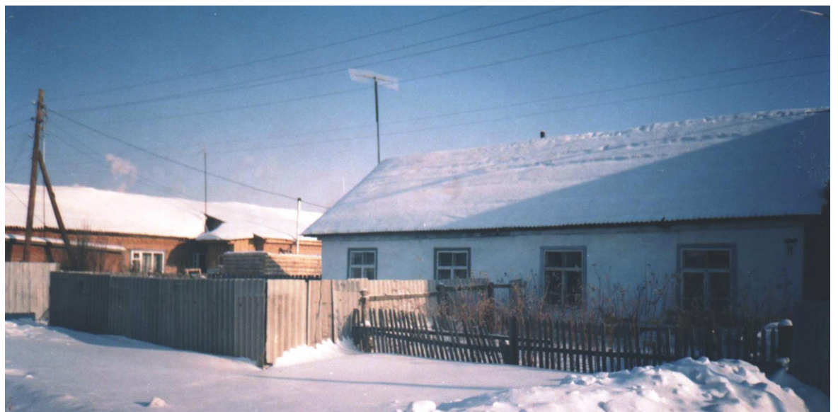
Первое здание д/сада. 1951 г. Слева – вновь построенное здание д/с. 1966. В нем размещалось три группы. В то время стены были оштукатурены, побелены в белый цвет, окна были деревянные.
